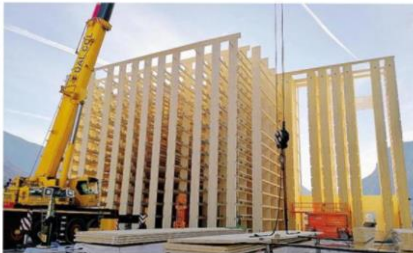
Lo «scheletro» tutto in legno del nuovo magazzino automatizzato che la società sta ultimando in Alto Adige
